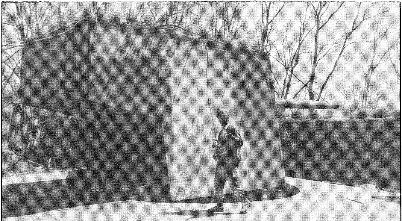
Установка МО-1-180. Батарея № 905, Владивосток.
